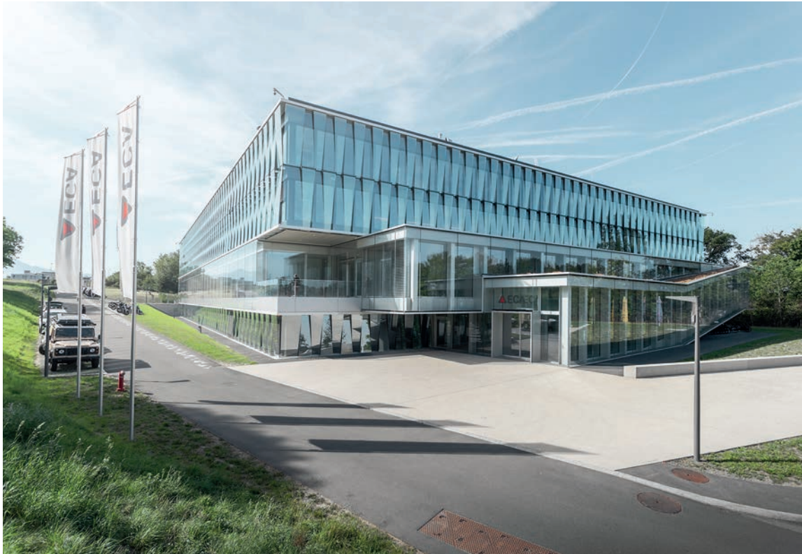
À partir du 1 er octobre prochain. La CTMG prendra ses quartiers dans la centrale commune aux centrales I17, I18 et
